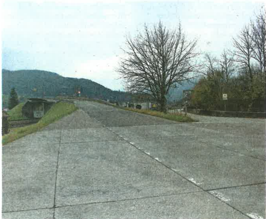
Hier in der Stegstuden in Ingenbohl soll auf der Seewenstrasse in ein paar Jahren der Hochkreisel gebaut werden.
